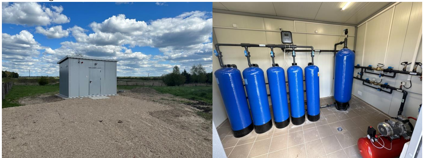
34 pav. Kabelių gyvenvietės vandens gerinimo įrenginių nauja statyba
