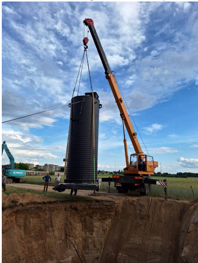
35 pav. Matuizų gyvenvietės pagrindinės buitinių nuotekų siurblynės statyba
