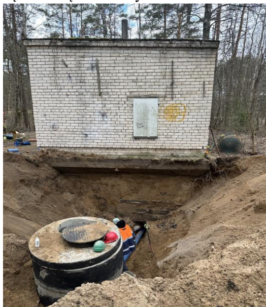
36 pav. N. Valkininkų gyvenvietės pagrindinės buitinių nuotekų siurblynės renovacija
